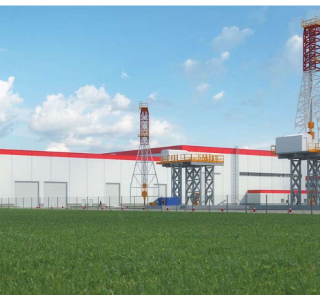
Завод NATIONAL OILWELL VARCO (г. Волгореченск)
