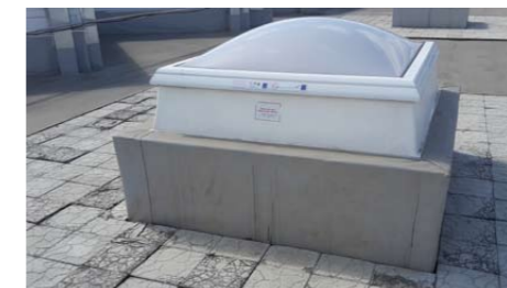
Рассечки при помощи тротуарной плитки
