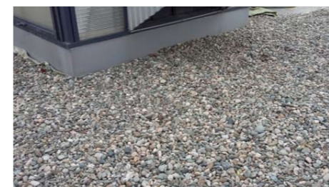
Рассечки при помощи гравийной отсыпки
